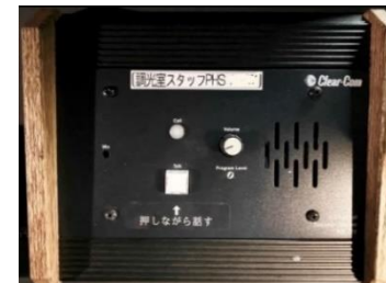
1chリモートステーション Clear-Com KB-701 ※調整室との連絡にご利用いただけます。
