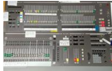
照明操作卓 松村電機 F105 ※照明の簡易操作は舞台袖でも可能です。
