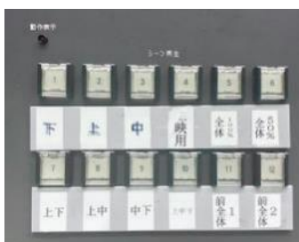
ボタン操作制御盤(部分) 照明(プリセット)操作パネル
