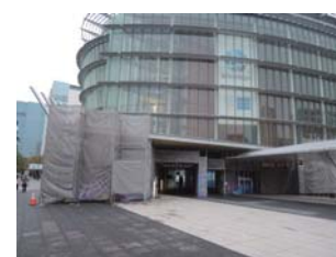
建物・設備の改修
