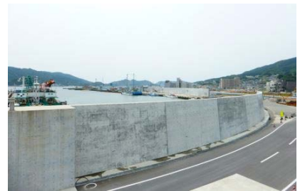
大船渡市に建設された防潮堤（写真提供：岩手県）
